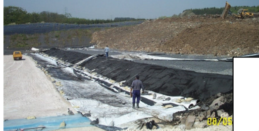
Erweiterung (Basisabdichtungsbau)
